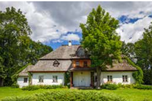
Dwór Tetmajerów w Łopusznej / The manor house of the Tetmajer family in Łopuszna, fot./photo by K. Bańkowski
